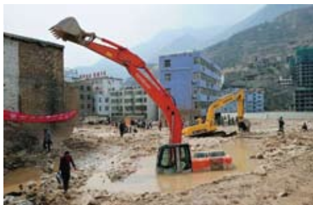
图6-3 大型工程车在舟曲县城疏通街道
