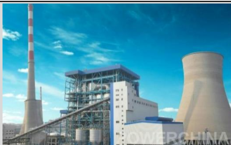
四川白马 600MW CFB 示范电站远景
